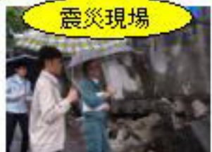
【住宅崩壊現場】
